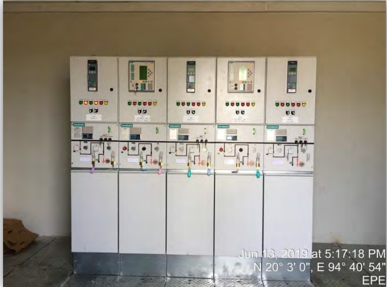
11kV SWITCHGEAR
